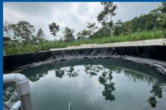
Tandon Penyimpanan Air Raksasa
